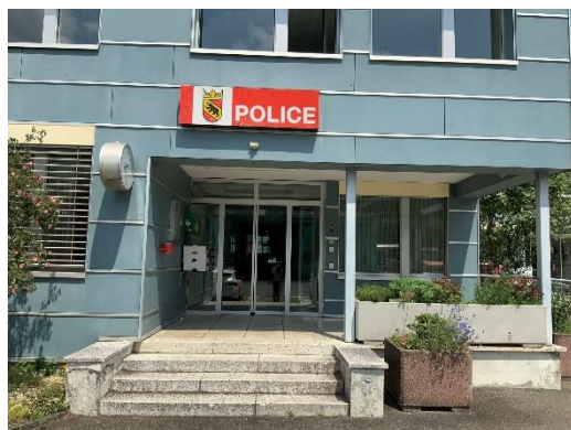
Abb. 5: Haupteingang Büros KAPO (Verwaltungsgebäude)
