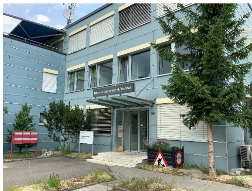
Abb. 3: Haupteingang Büros GE I (Verwaltungsgebäude)
